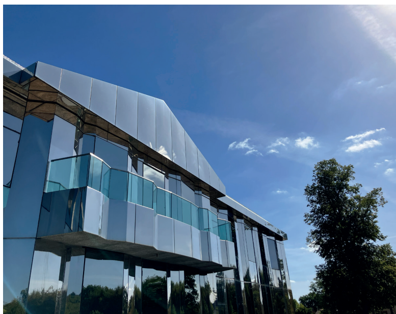
Le château de Rentilly, transformé en 2013.
